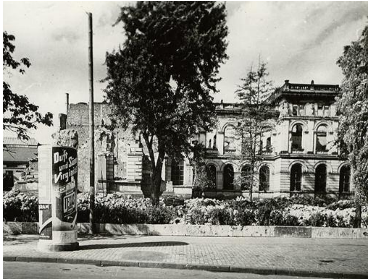
Zerstörtes Hauptgebäude von außen: Signatur 2.1.10_d (Quelle: Hochschularchiv)
